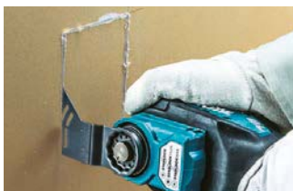
Découpe de plaques de plâtre
