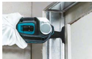
Travaux d'ouverture de porte
