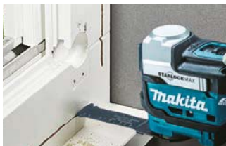
Dépose du cadre de fenêtre
